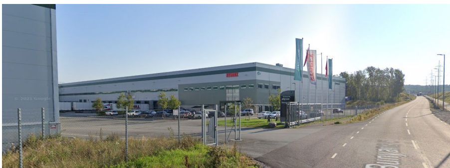
Den aktuella platsen september 2021. I bygglovshandlingarna står det att grinden ska hållas låst i väntan på en planändring.
